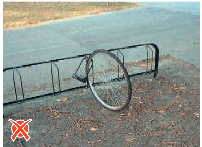
Abb. 3: Ungeeignete Vorderradklemmen, kein Wegrollschutz, daher kein stabiler Stand, Foto: Stadt Salzburg.
