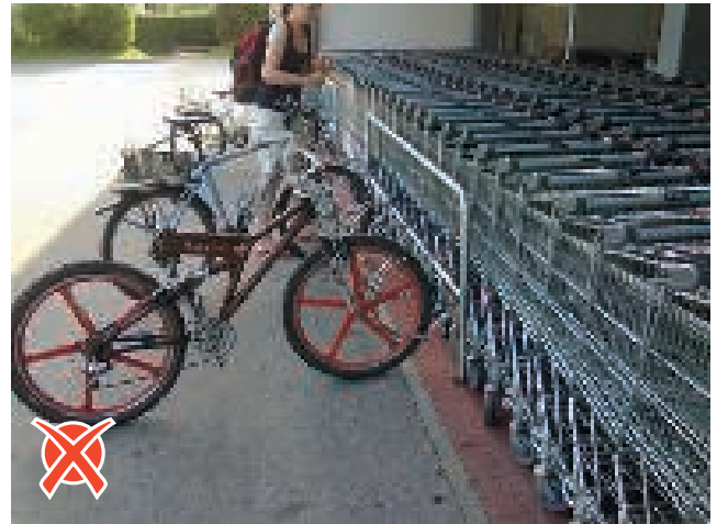
Abb. 22: Vorderradklemmen: kein Wegrollschutz, daher kein stabiler Stand, Foto: H. Hammerschmidt.
