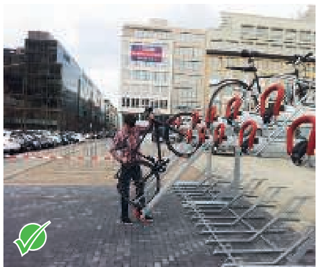
Abb. 39: Beispiel eines benutzerfreundlichen Doppelstock-Parkers (Modell Easylift, Fa. Innovametal), Foto: Velopa.
